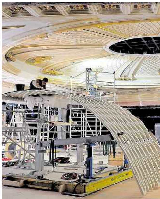
Die Unvollendete. Auf Berlins zweitgrößter Problemabstelle, der Staatsoper, gibt es bis zur offiziellen Übergabe im kommenden Frühjahr noch viel zu tun. Im Bild: Die Kuppel des großen Saales wird mit einer Nachhallgalerie ausgerüstet.
